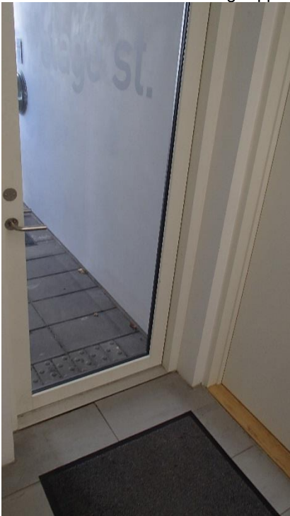
Fuger rundt om ind- og udvendige døre, kontrolleres jævnligt for tæthed.
