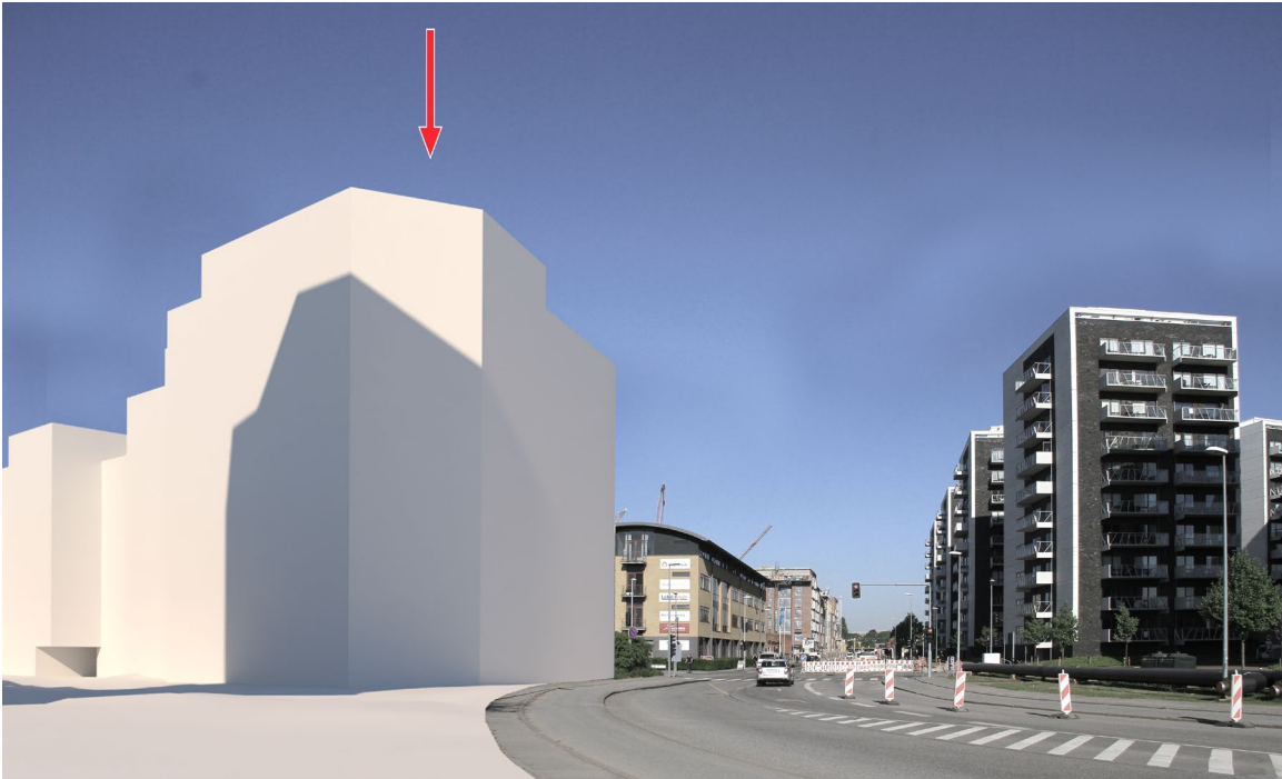
Set fra punkt 3, Søren Frichs Vej (fra øst mod vest) bygningen som lokalplanen omfatter er vist med rød pil.
