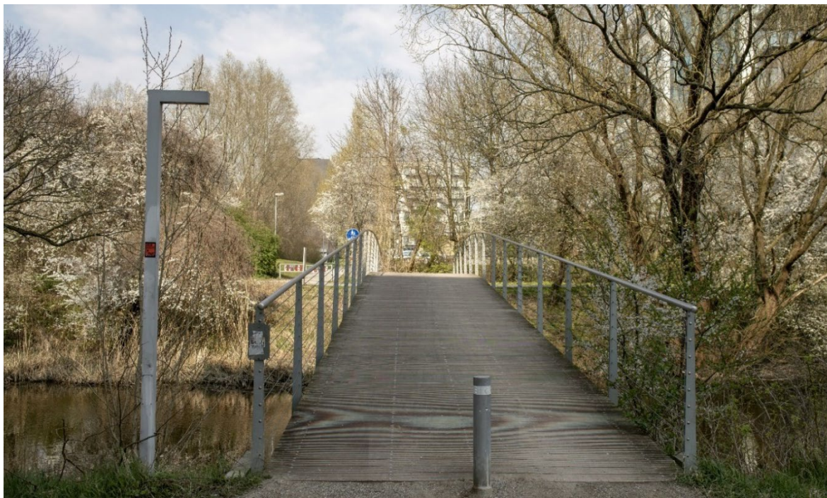
Fotostandpunkt 3: Eksisterende forhold
