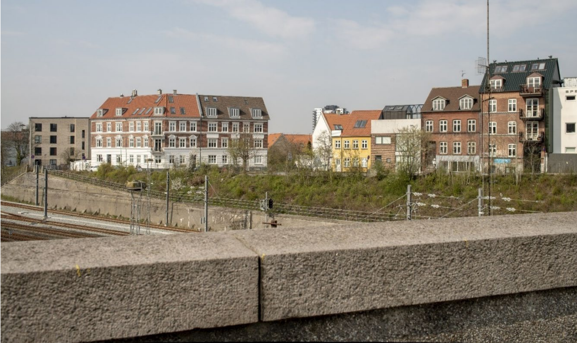
Fotostandpunkt 6: Eksisterende forhold
