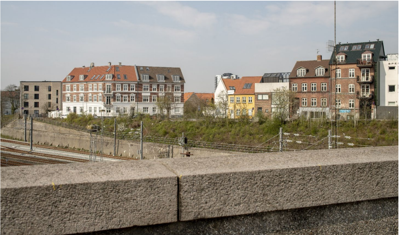
Fotostandpunkt 6: Eksisterende forhold
