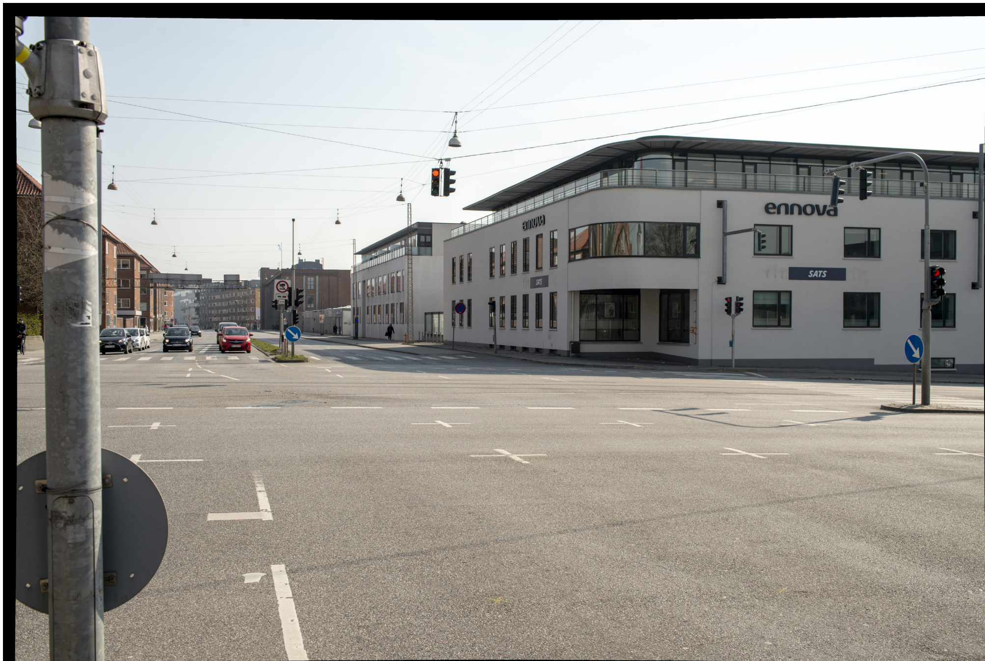
Fotostandpunkt 1: Eksisterende forhold
