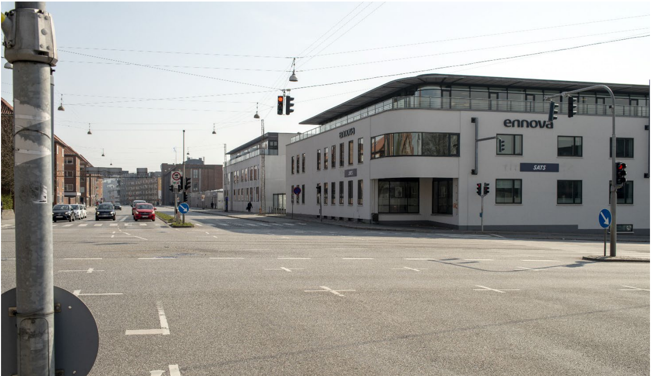
Fotostandpunkt 1: Eksisterende forhold
