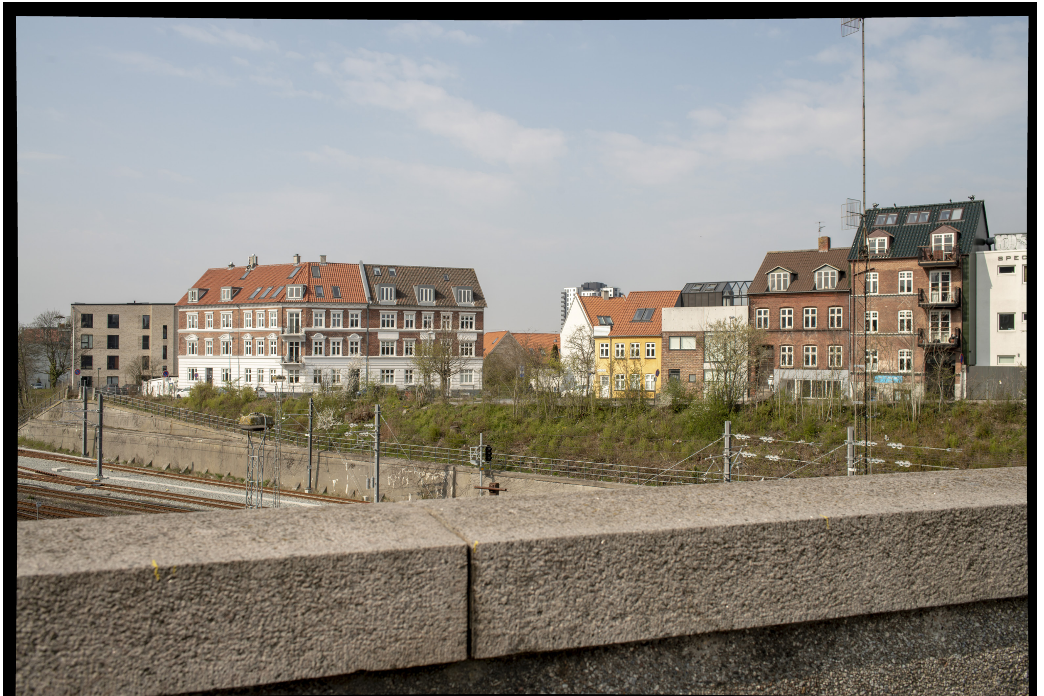
Fotostandpunkt 6: Eksisterende forhold
